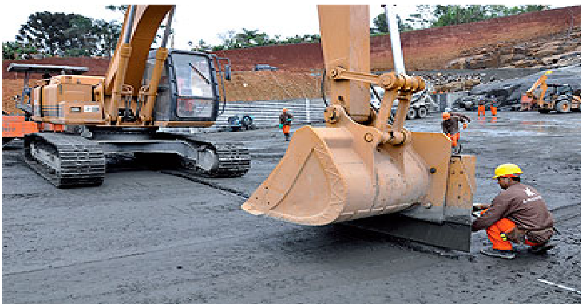
Figura 7 – Processo de concreto compacta do rolo Fonte: UHE Mauá (2011)
