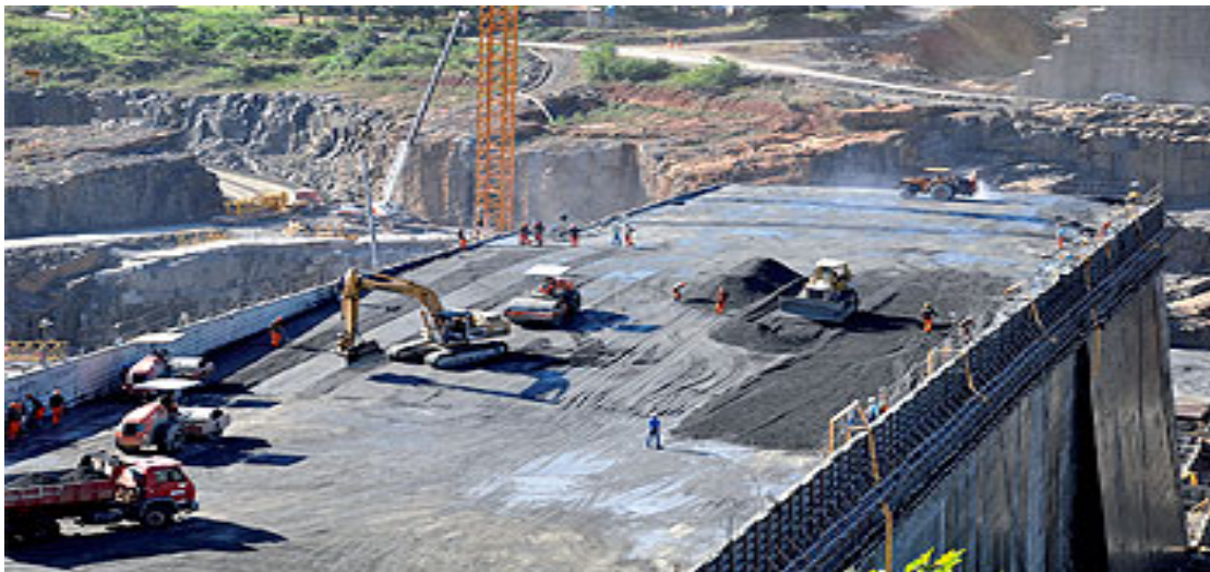
Figura 6 - As camadas são colocadas com pequena inclinação de 10% com relação à horizontal de modo a permitir o acesso do rolo Fonte: UHE Mauá (2011)
