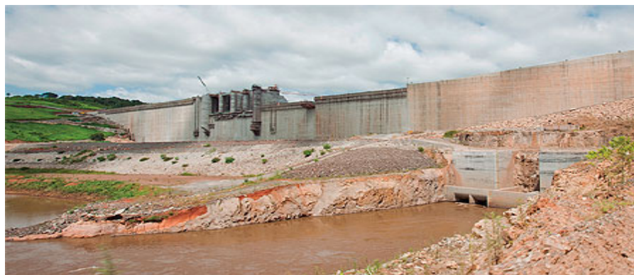
Figura 10 - Desvio do rio foi feito por baixo da barragem por meio de dois condutos que serão fechados após a conclusão da obra Fonte: UHE Mauá (2011)
